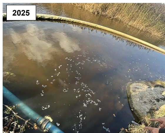
Figur 3-1. Bilder tatt før og etter mudring. Bildene før mudring (til venstre) ble tatt 4. oktober 2024, før det ble mudret første gang i Røyrvikshølen. Bildene etter mudring (til høyre) ble tatt 30. september i 2025. Bildene i 2025 viser klart vann med synlig effekt av mudring innerst ved stranden (til venstre) og i siltgardin (til høyre).
